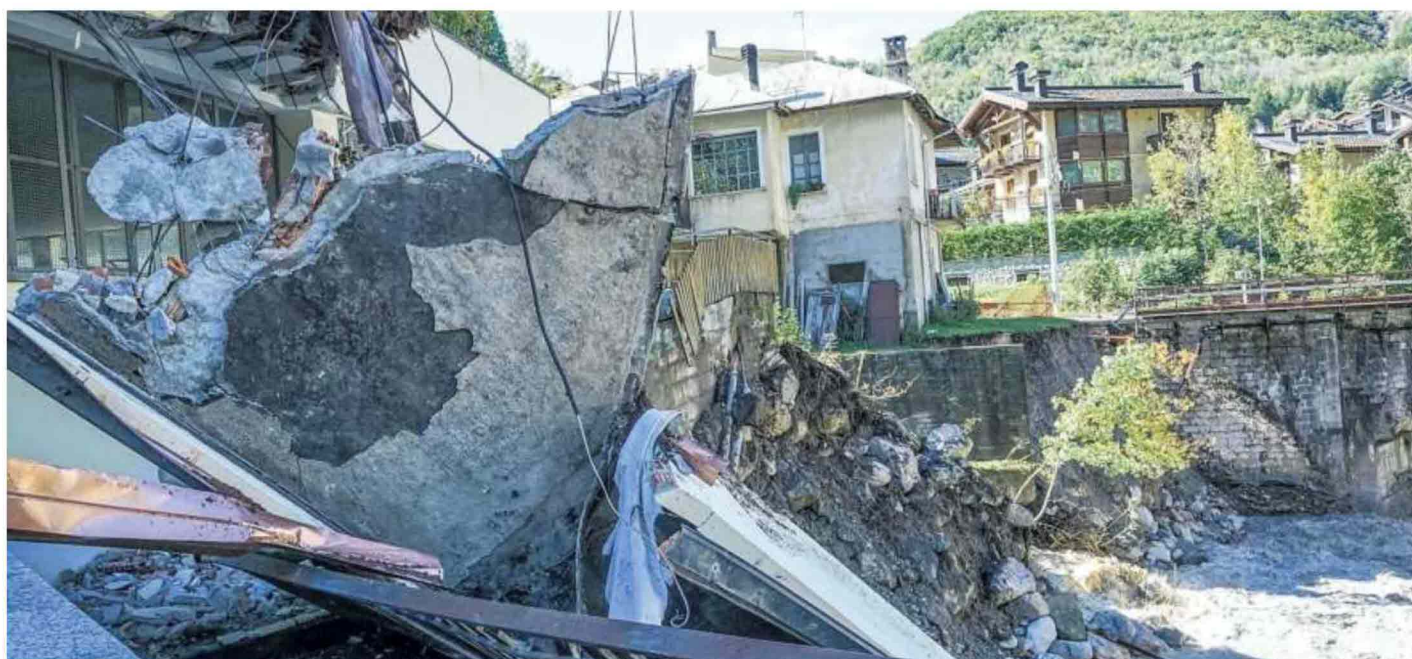
Un'immagine del centro di Limone Piemonte, in provincia di Cuneo, che è rimasto isolato
