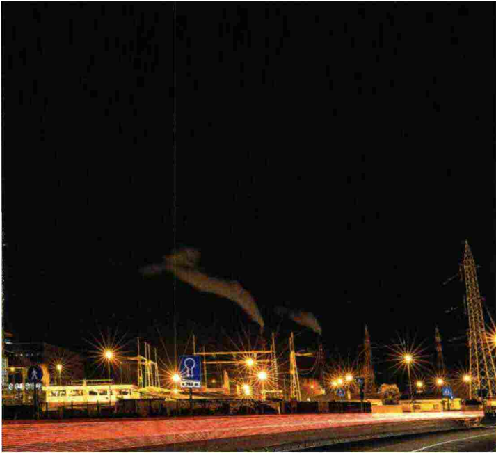
La centrale termoelettrica a Porto Marghera (Ve). L'energia da fonti non rinnovabili nel nostro Paese è pari a oltre il 70 per cento della produzione.
