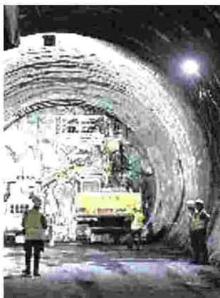
Un cantiere della linea ad alta velocità Torino-Lione
