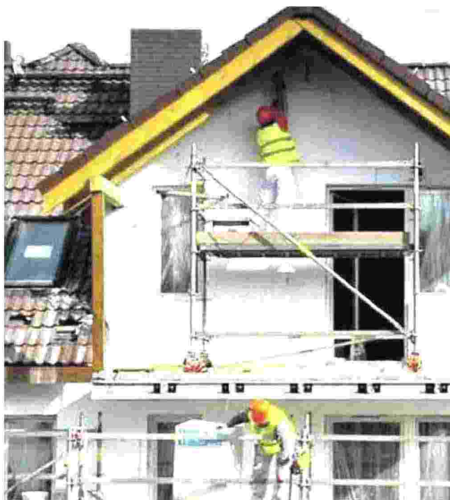
Un intervento di ristrutturazione edilizia
