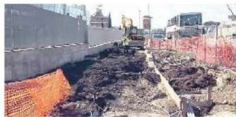
Un cantiere stradale nella Capitale
