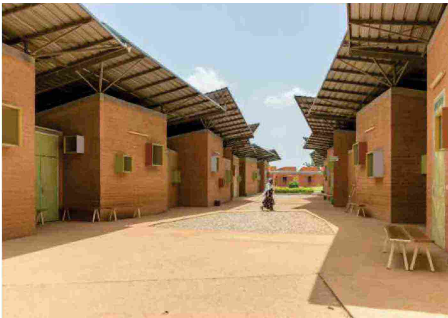
Nella pagina accanto: il progetto per l'Assemblea nazionale del Benin. Qui a sinistra: il cortile del centro medico chirurgico di Léo, in Burkina Faso, completato nel 2014. In basso: un ritratto di Diébédo Francis Kéré.
