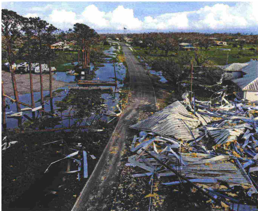
I danni causati dal ciclone Ida a Pointe-Aux-Chenes, Louisiana
