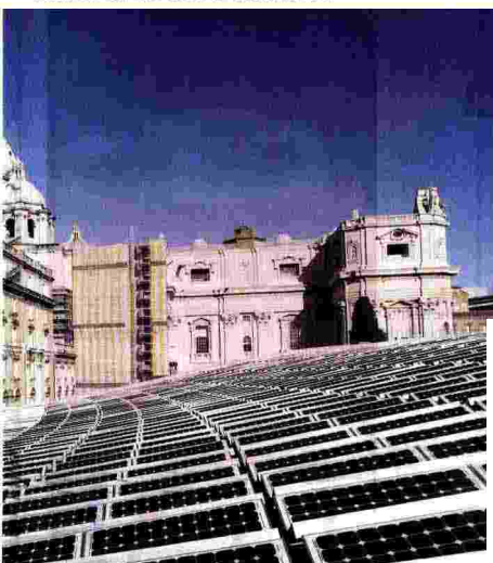
Pannelli. Installazioni di pannelli fotovoltaici sui tetti. FOTO: CONTRASTO
