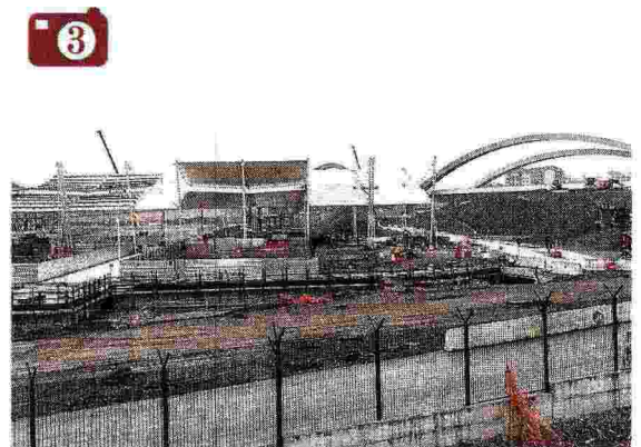
Uno dei cantieri aperti: l'interconnessione con la statale 11
