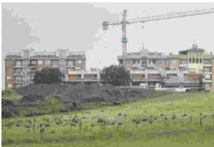
Un cantiere nella periferia di Roma
