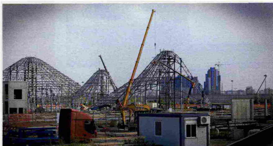
DUE IMMAGINI DEL CANTIERE DELL'AREA ESPOSITIVA, CHE SARÀ INAUGURATA IL PRIMO MAGGIO
