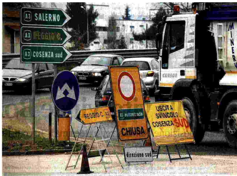
Lavori fermi. Dalle opere per la viabilità ai problemi idrici, dalle scuole da mettere in sicurezza alla mancanza di lavoro: le emergenze di Reggio Calabria
