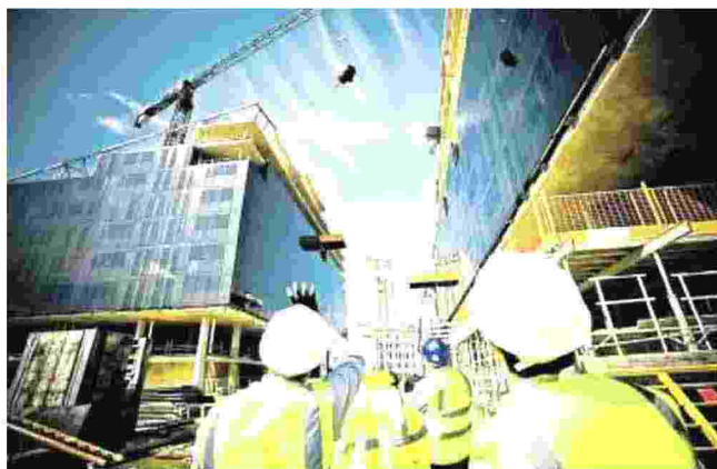
Cantieri all'opera, per il Superbonus scadenza dicembre 2022
