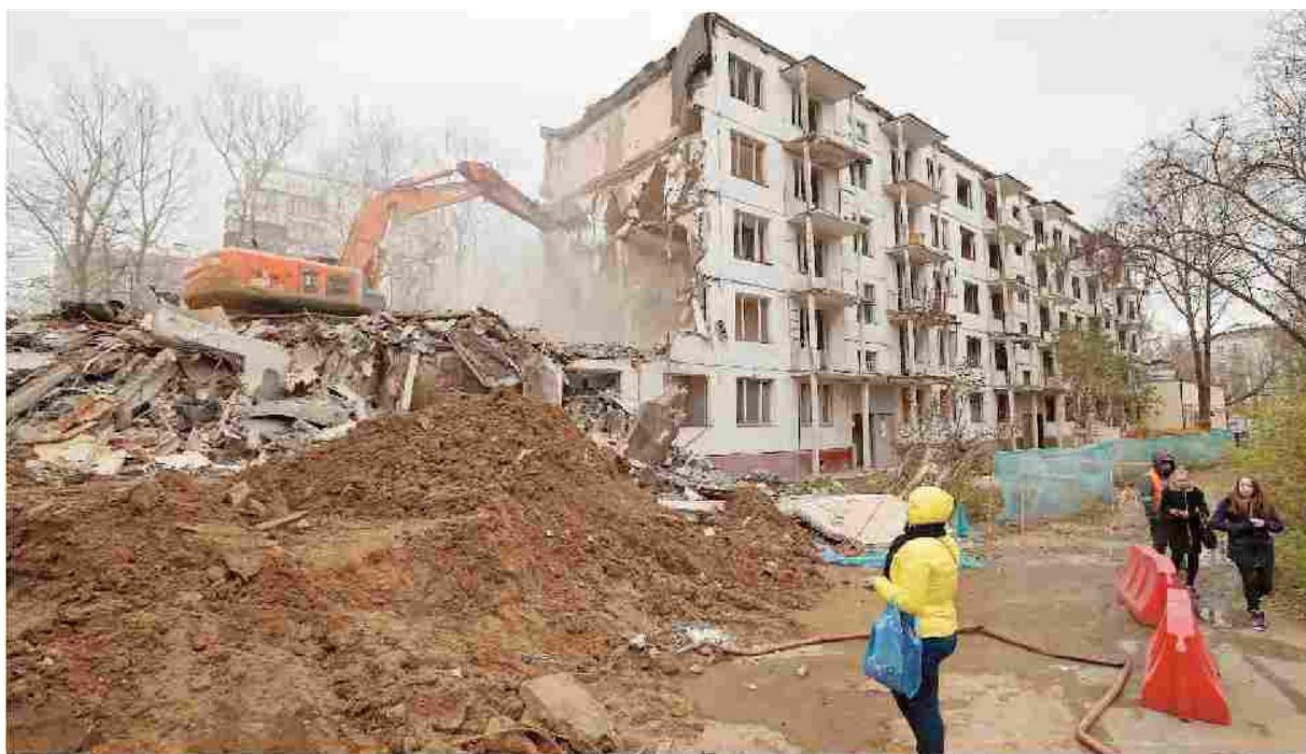
Un'abitante di una «krusciovka» di Mosca osserva le operazioni di demolizione
