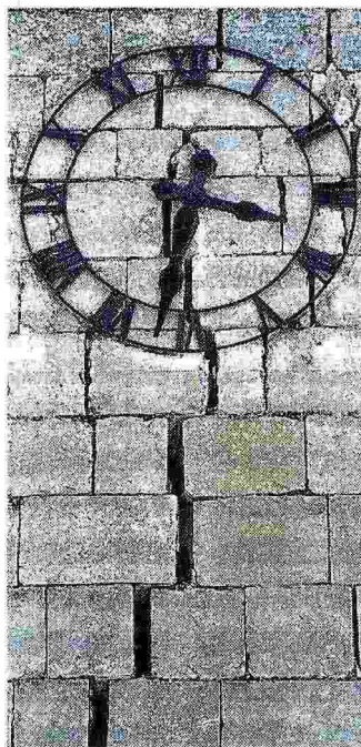
Alle 3.32 Le lancette ferme dell'orologio della chiesa di Sant'Eusanio (L'Aquila)
