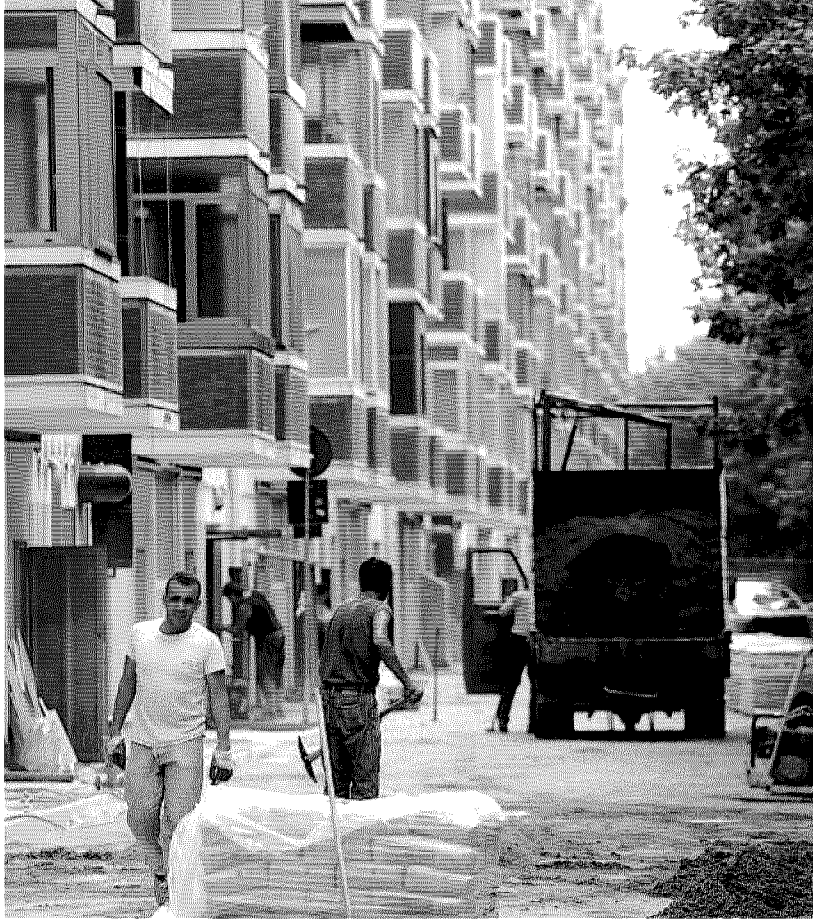
Lavori di ristrutturazione a un palazzo Aler
