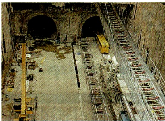
Un cantiere per la costruzione di una linea metropolitana
