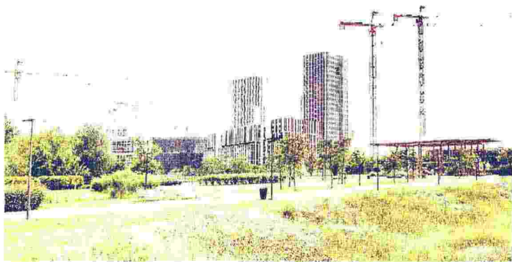
Al lavoro. Cascina Merlata, alle porte di Milano, area in corso di rivitalizzazione
