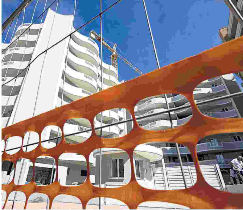
▲ Un edificio in ristrutturazione
