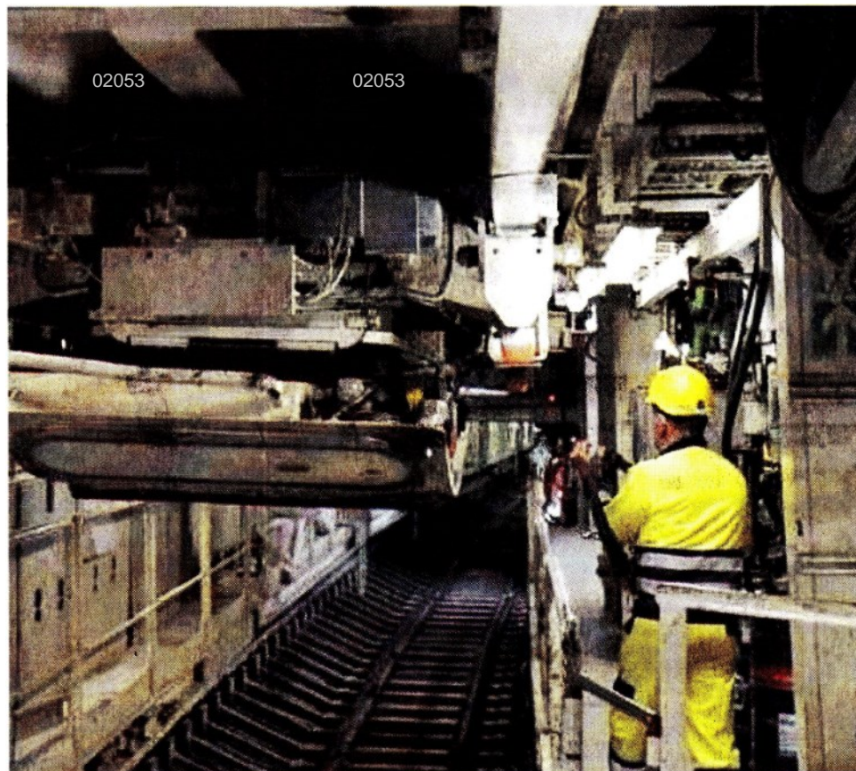
Un operaio nel cantiere della metropolitana
