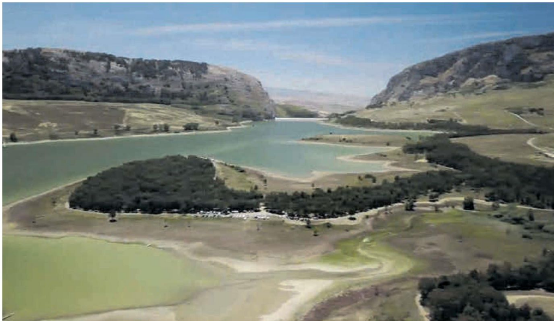
Siccità nell'invaso della diga di Piana degli Albanesi
