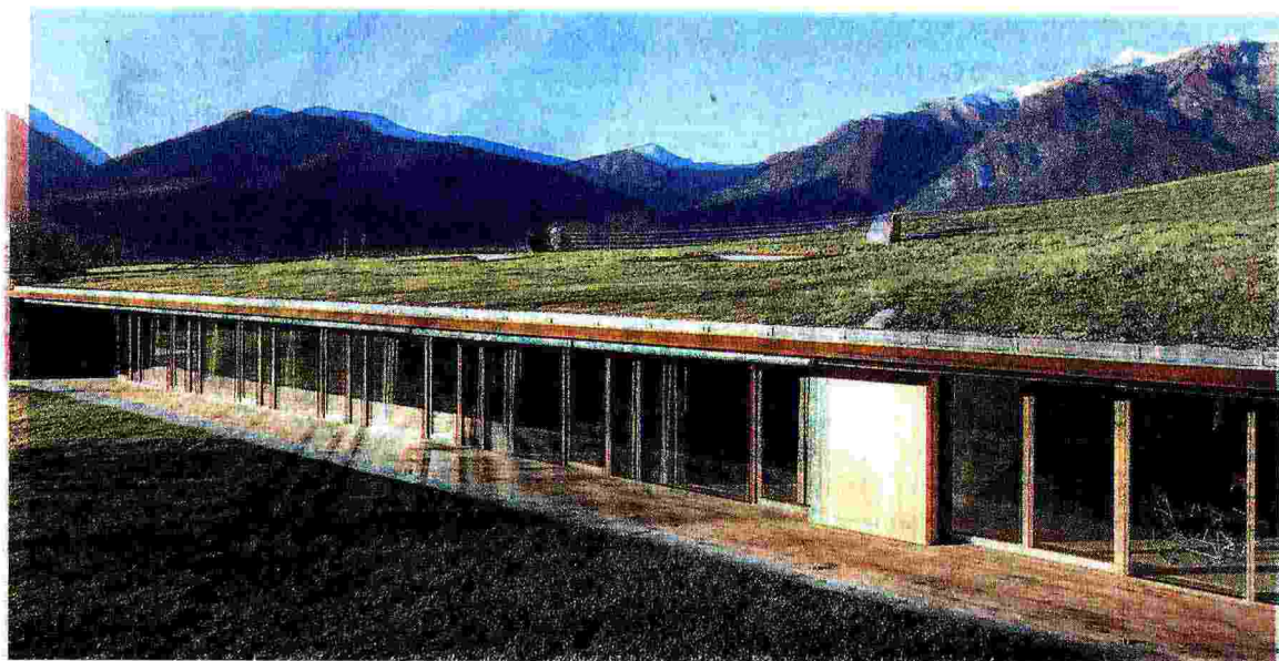
Un prato sul tetto. Casa Riga a Comano Terme (Tn) è un b&b in legno inglobato nel terreno: finalista a CasaClima 2016
