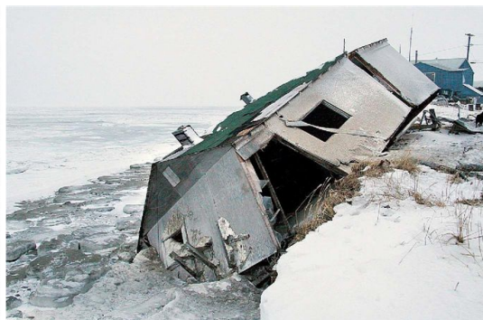
Disastri Una casa in Alaska, crollata verso la scogliera in seguito alla cedevolezza del terreno
