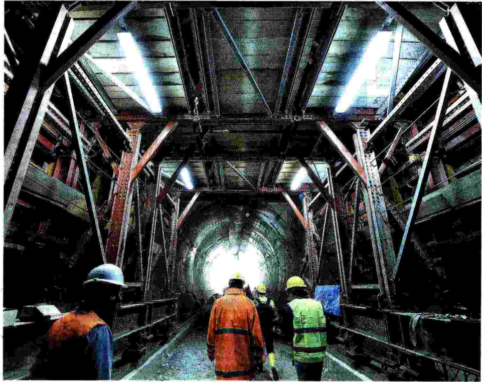
Il tunnel sotto le Alpi. Il cantiere della Tav a Chiomonte: secondo l'analisi tecnica pubblicata ieri dal Mit i costi superano di 7-8 miliardi i benefici
