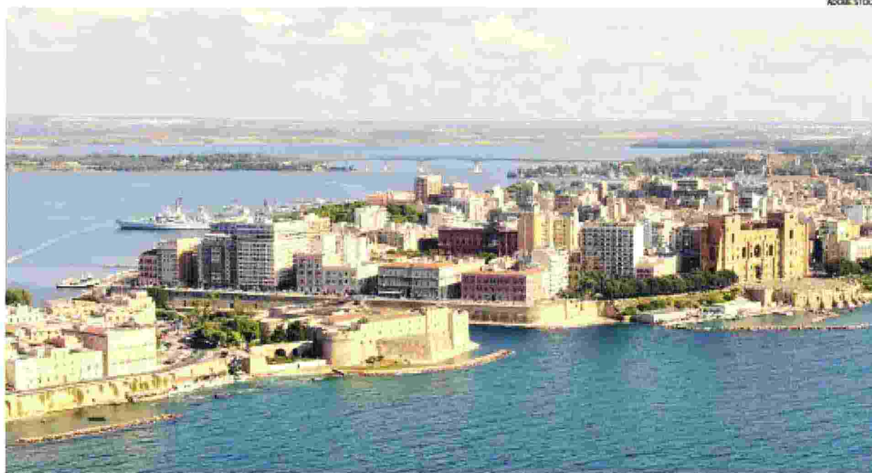
La città dei due mari. La parte più antica di Taranto è bagnata dai cosiddetti "due mari", Mar Piccolo e Mar Grande, e collegata al resto della città dal famoso ponte girevole e un ponte di pietra.
