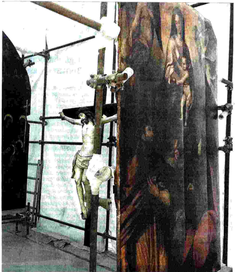
Lavori in corso. Nella Chiesa di San Pietro Martire, a Napoli, il restauro del crocifisso e delle tavole Laurito e Santafede
