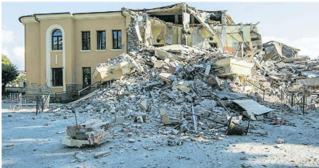
La scuola "Capranica" di Amatrice, distrutta dal terremoto del 2016
