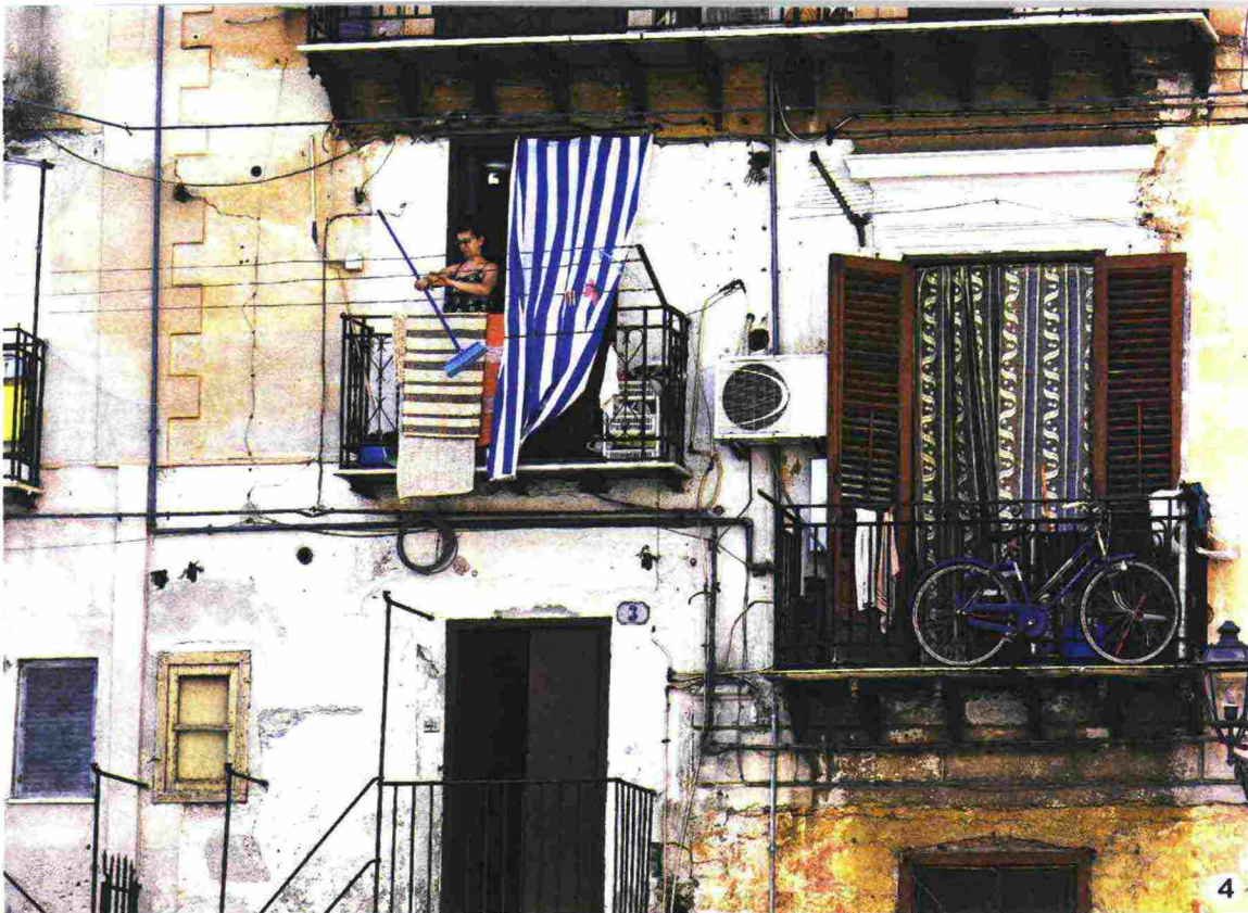
4 La facciata di una casa popolare nel quartiere della Kalsa.
