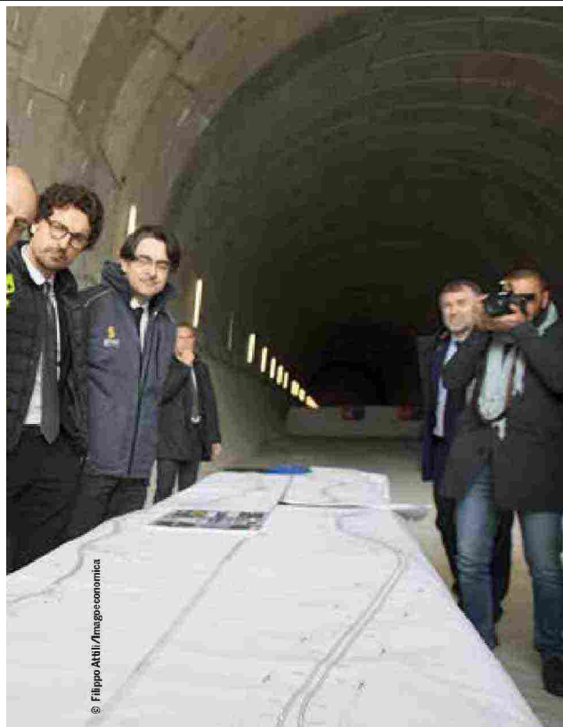
Conte e Toninelli al cantiere della strada statale 640 Calanisetta-Agrigento. 12 marzo 2019 In apertura. La stazione non completata e abbandonata della ferrovia Matera-Bari
