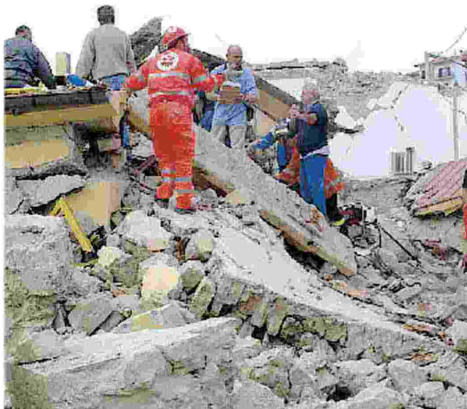
STRAGE La scuola crollata per un terremoto, nel 2002, in Molise
