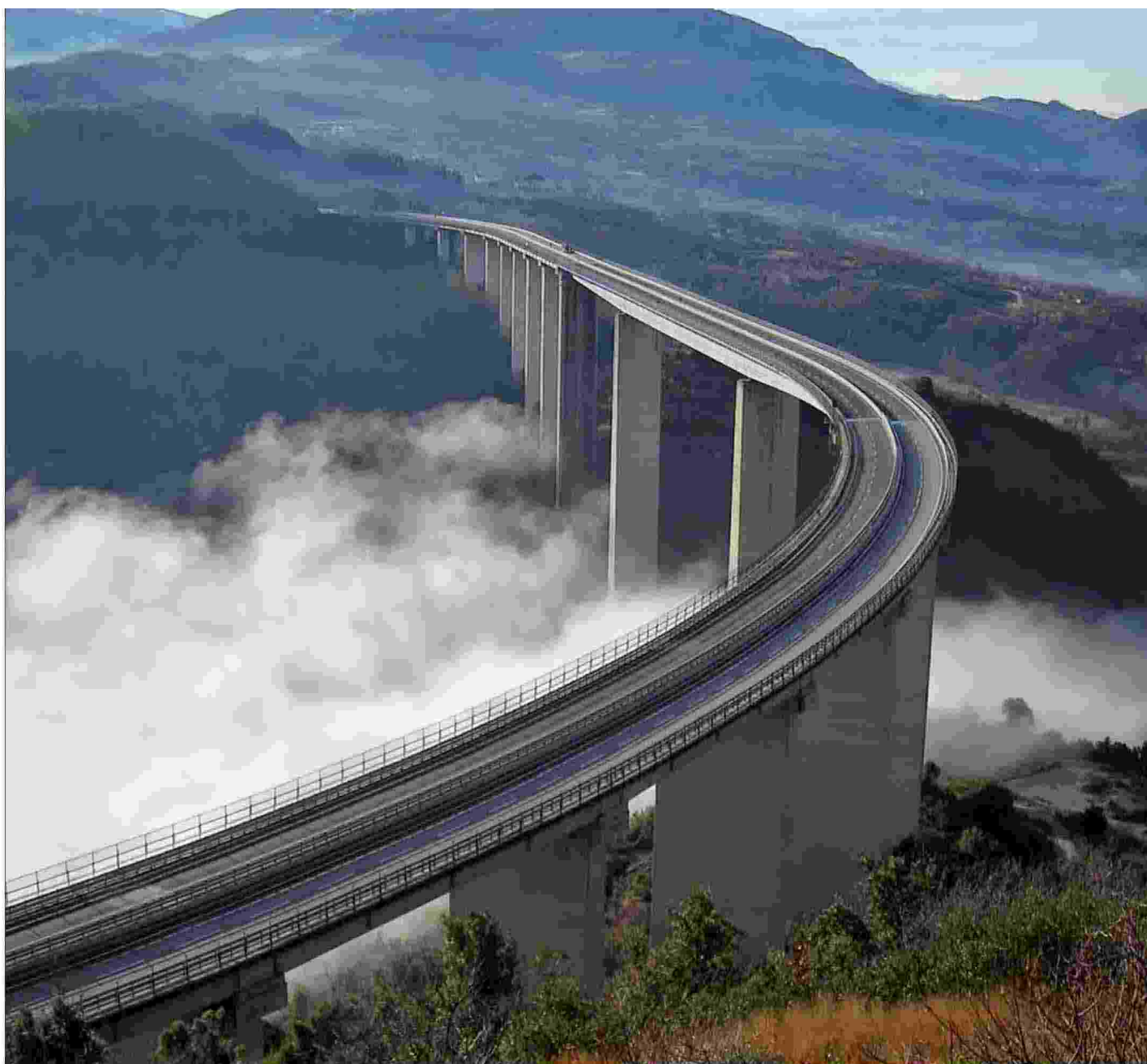
Il viadotto Italia, oggi in via di ristrutturazione, forse l'opera più innovativa dell'autostrada Salerno-Reggio Calabria. In calcestruzzo e acciaio, è il secondo viadotto più alto in Europa
