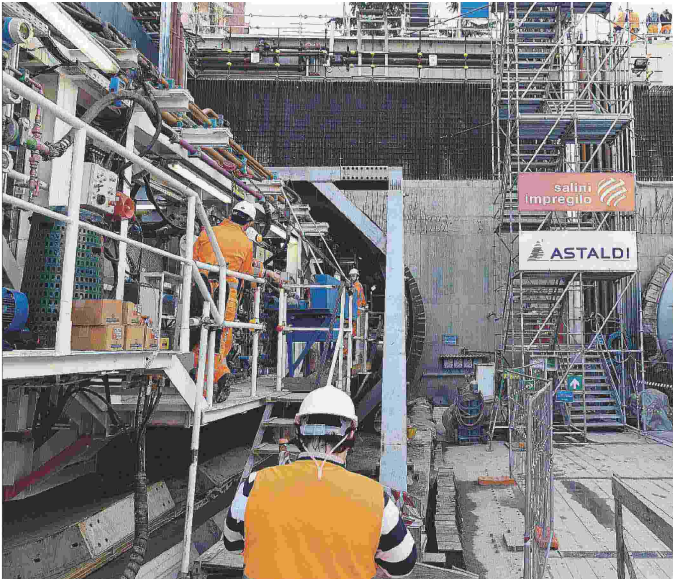
Un cantiere della linea M4 della metropolitana milanese (Imagoeconomica)
