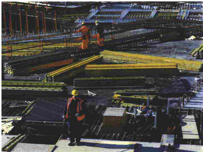
Il cantiere della stazione Foster nell'area ex Macelli
