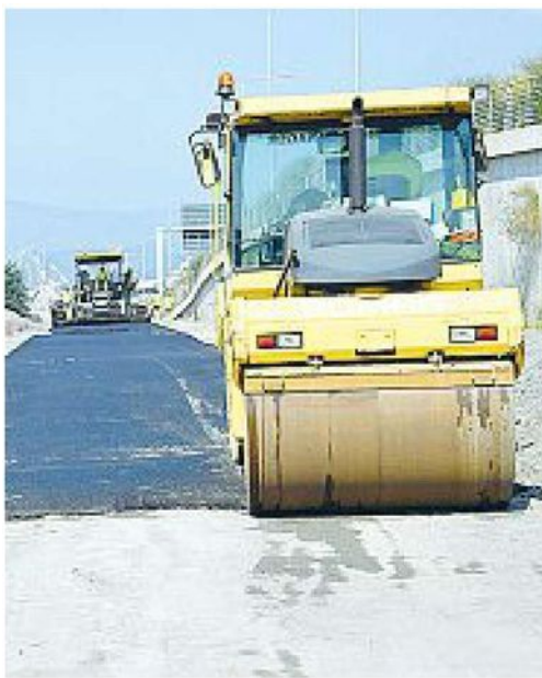
I cantieri Sono partiti i lavori di pavimentazione per la nuova viabilità dei mezzi pesanti nell'area del ponte
