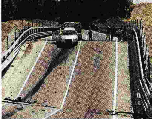
La galleria incompiuta di Guinza , tra le Marche e l'Umbria, e i viadotti crollati di Petrulla e Himera in Sicilia
