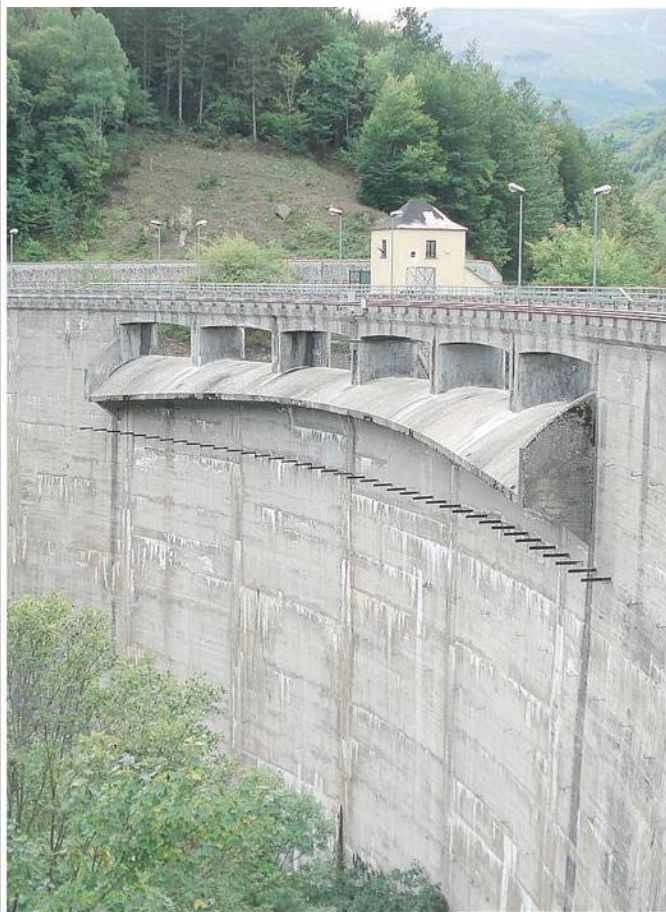
Sotto osservazione. La diga di Campotosto sul Rio Fucino
