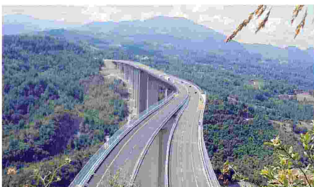
Il viadotto Italia dopo i lavori sulla Salerno-Reggio Calabria
