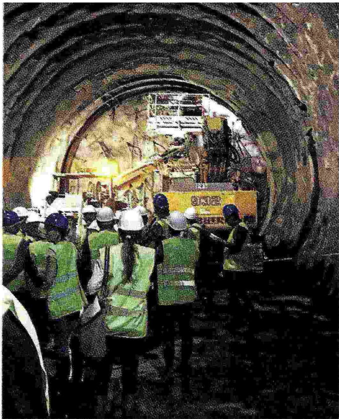
Operai al lavoro nel cantiere della Torino-Lione a Saint Martin la Porte
