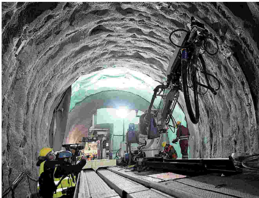
Operai al lavoro nel tunnel per la Tav Torino-Lione, in località Chiomonte (Ansa)
