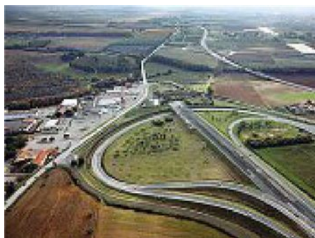
I lavori Un tratto dell'Autostrada Tirrenica
