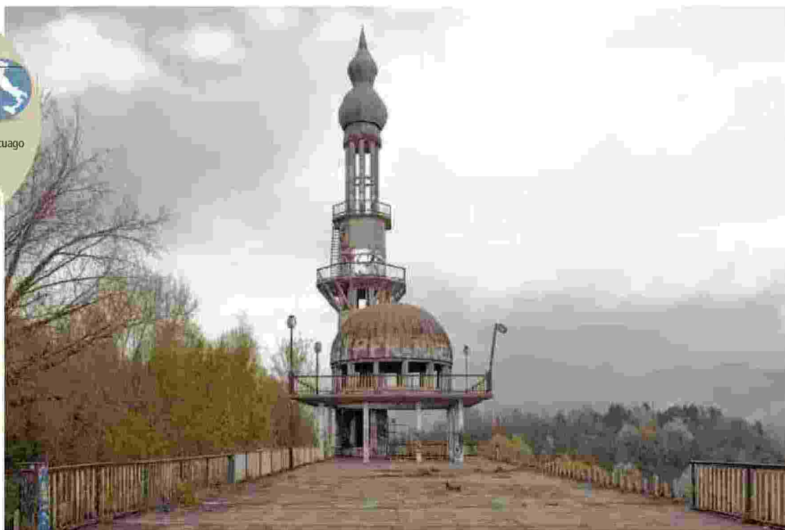
Lo scheletro del centro commerciale di Consonno: una struttura in stile moresco, con tanto di minareto
