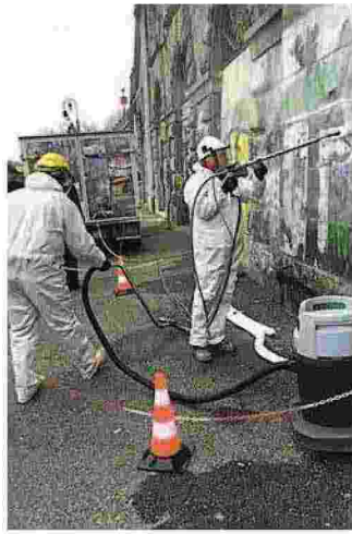
La rimozione dei graffiti ai “Muri”
