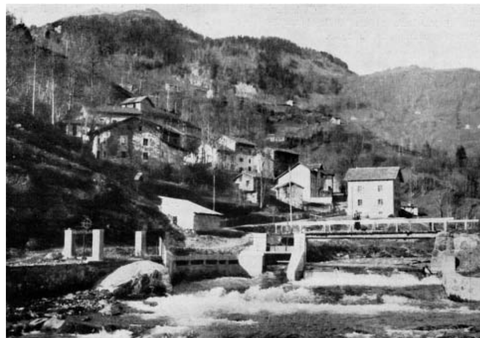
Opere di presa sul Torrente But, all' altezza del ponte per Cleulis.
