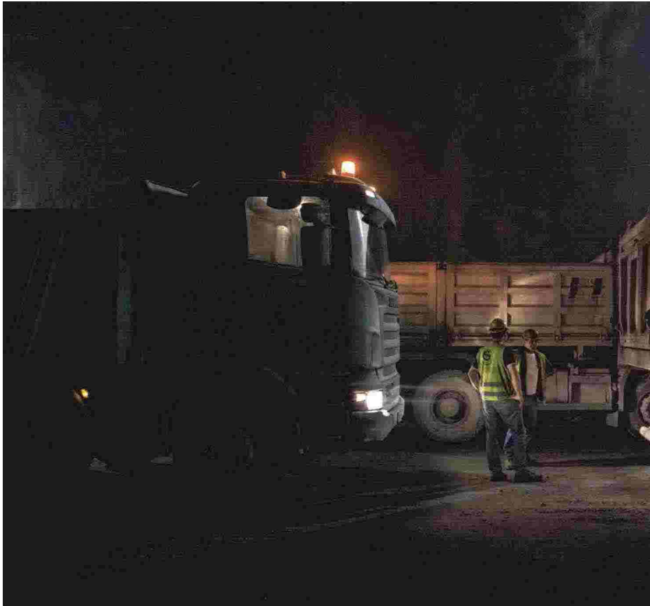
OPERAI ADDETTI AL TRASPORTO DEI DETRITI AL DI FUORI DEL CANTIERE DI MULES
