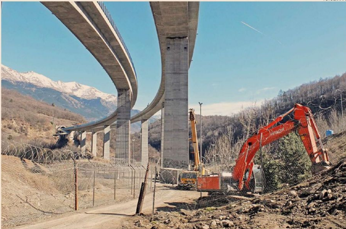
Tav Torino Lione I lavori per la costruzione della linea ferroviaria ad alta velocità Torino-Lione. L'opera è in attesa dell'analisi costi-benefici annunciata del Governo.
