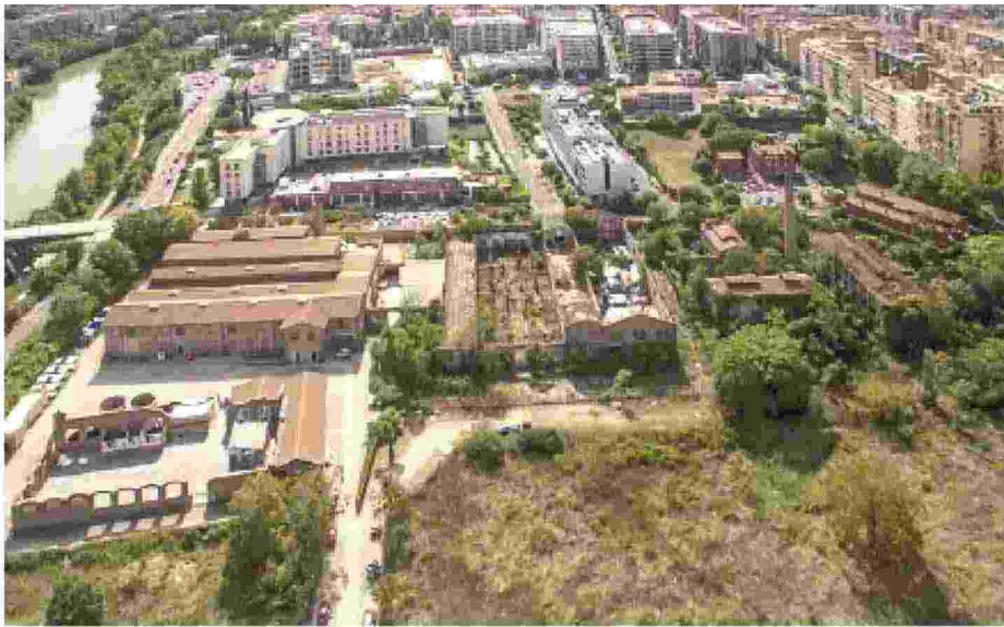
Ex Mira Lanza. Esempio di archeologia industriale, il sito è al centro del progetto di rigenerazione urbana del Campidoglio
